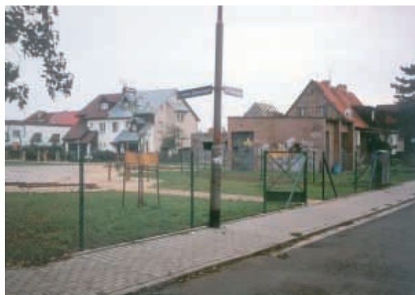
Dzikie wysypisko przy ul. Australijskiej po uporządkowaniu
