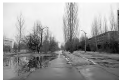
Fot. 24.12. Elektrownia w Czarnobylu (u góry) oraz opuszczone miasto Prypeć, powstałe na potrzeby pracowników elektrowni (na dole). Fot. Nik Stanbridge
