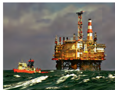
Fot. 10.4. Platforma Magnus, położona w brytyjskiej północnej części Morza Północnego, składa się z 71 000 ton stali.
