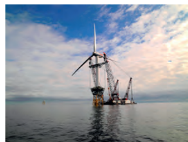
Fot. 10.8. Budowa demonstracyjnej „głębokiej” farmy wiatrowej Beatrice. Fotografie udostępnione przez Talisman Energy (UK).
